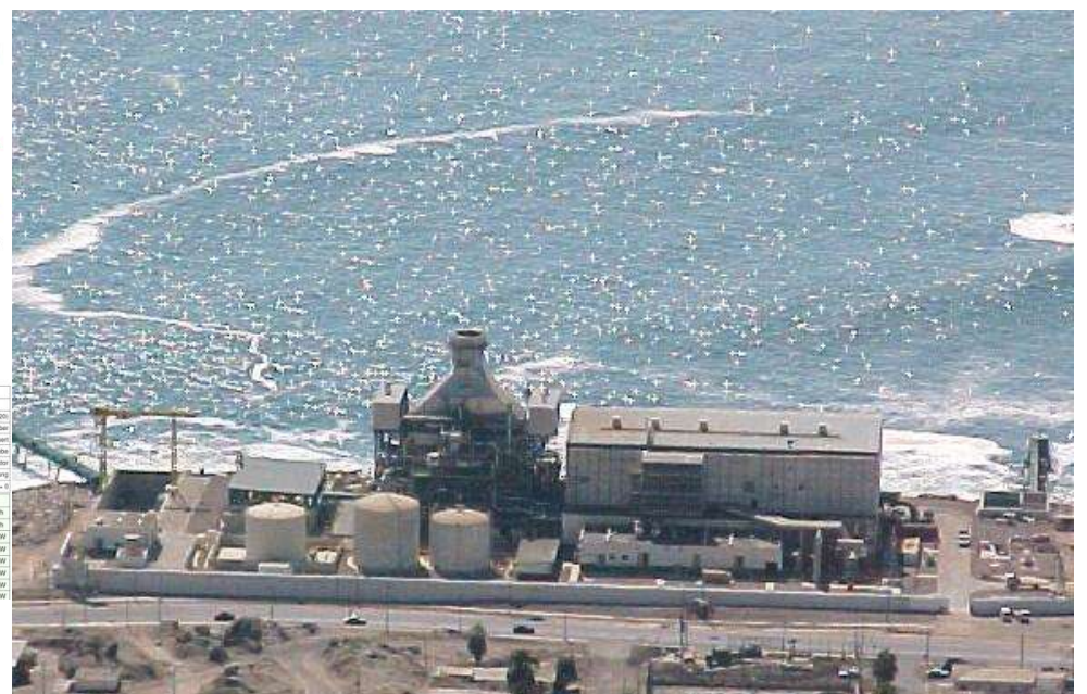
Realisiertes GuD-Kombi-Kraftwerk (Elektr. Leistung P_{el} 400 MW)
